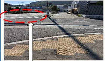
写真②：横断歩道・歩道の状況（東側から西側向き）
